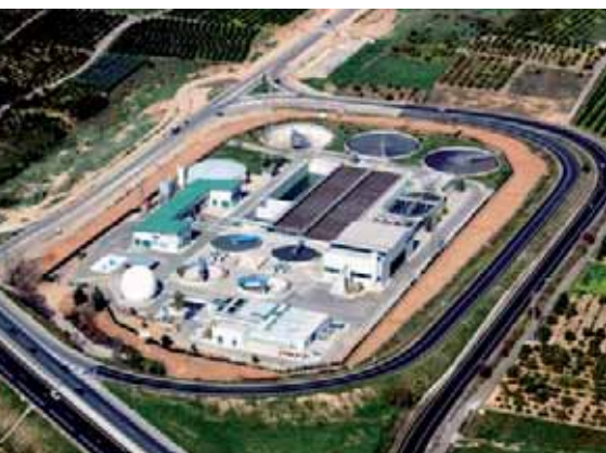
La depuradora Paterna-Fuente del Jarro
