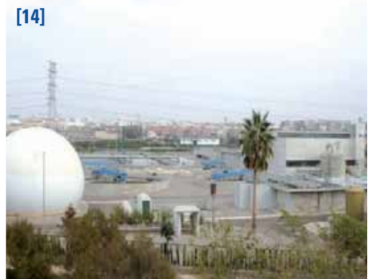
Depuradora de Paterna-Fuente del Jarro
